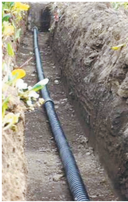
深さ80cmに設置した透水管
